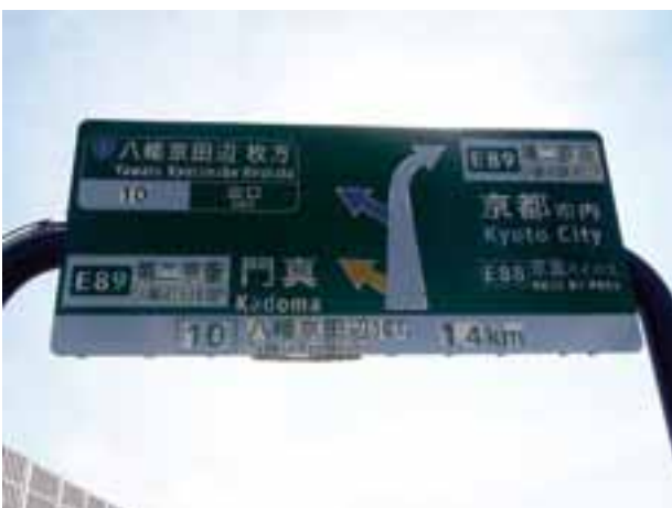
【新名神高速道路-八幡京田辺JCT-逆光対策標識】
